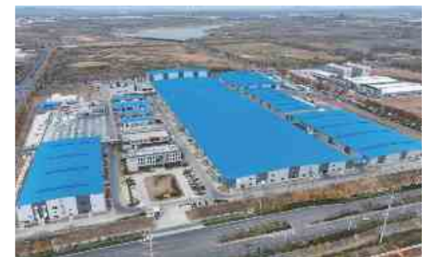
滁州储能工厂俯瞰图
