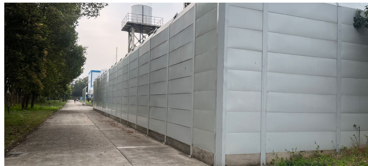
▲ 南硬公司在厂区安装隔音板用于减少噪音污染
